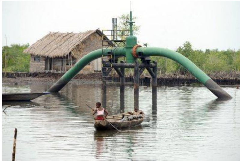
Рисунок – 1.7 Головні споруди підводного трубопроводу в дельті Нігера
