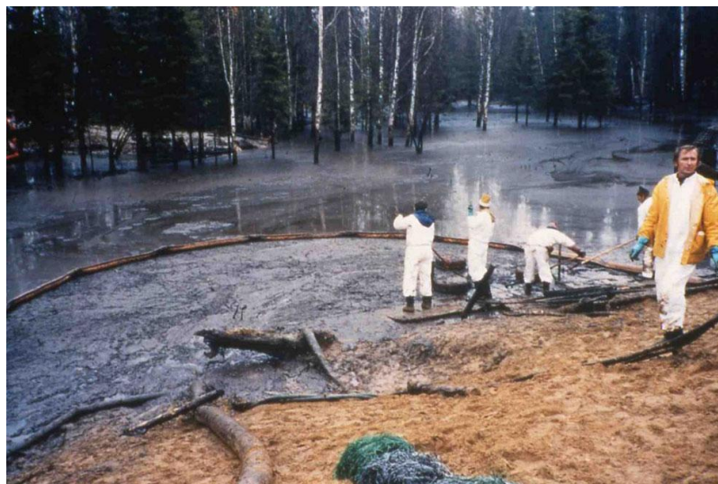
Рисунок – 1.6 Ликвідація наслідків прорива трубопроводу в Республіке Коми
