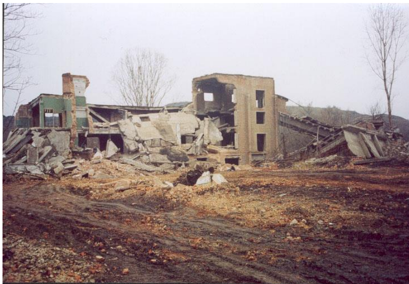
Рис. 3.10 Зруйнований комплекс будівель на майданчику шахти "Об'єднана"
