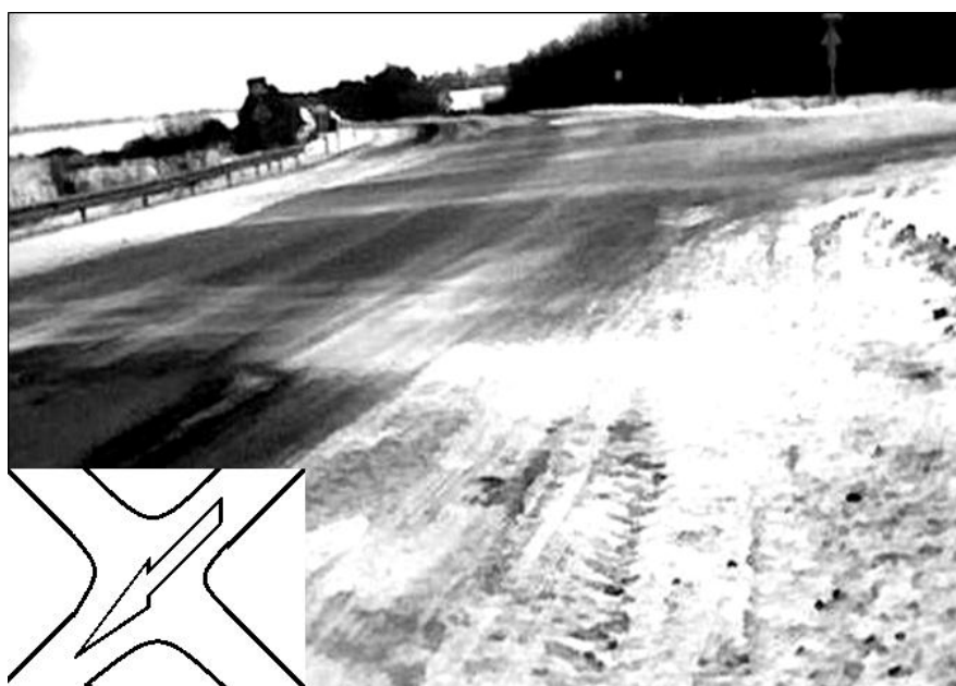
Рис.3.27. Утворення снігового “перемету” внаслідок впливу “крайового ефекту” в зоні розриву суцільності масиву газо-пилозахисної смуги автомобільної дороги
