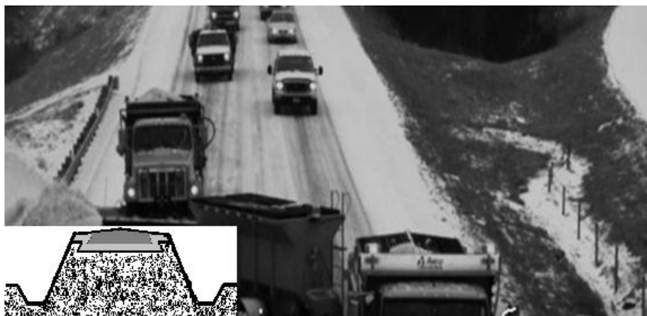
Рис.3.28. Характер преципітації вільнодиспергованого у повітрі “снігового” грубодисперсного аерозолу при розташуванні автомобільної дороги на насипу ( https://www.ukrinform.ua )
