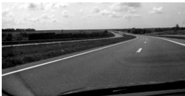
Рис.1.13. Відсутність засобів захисту на ділянці автодороги М-18 Харків-Дніпропетровськ
