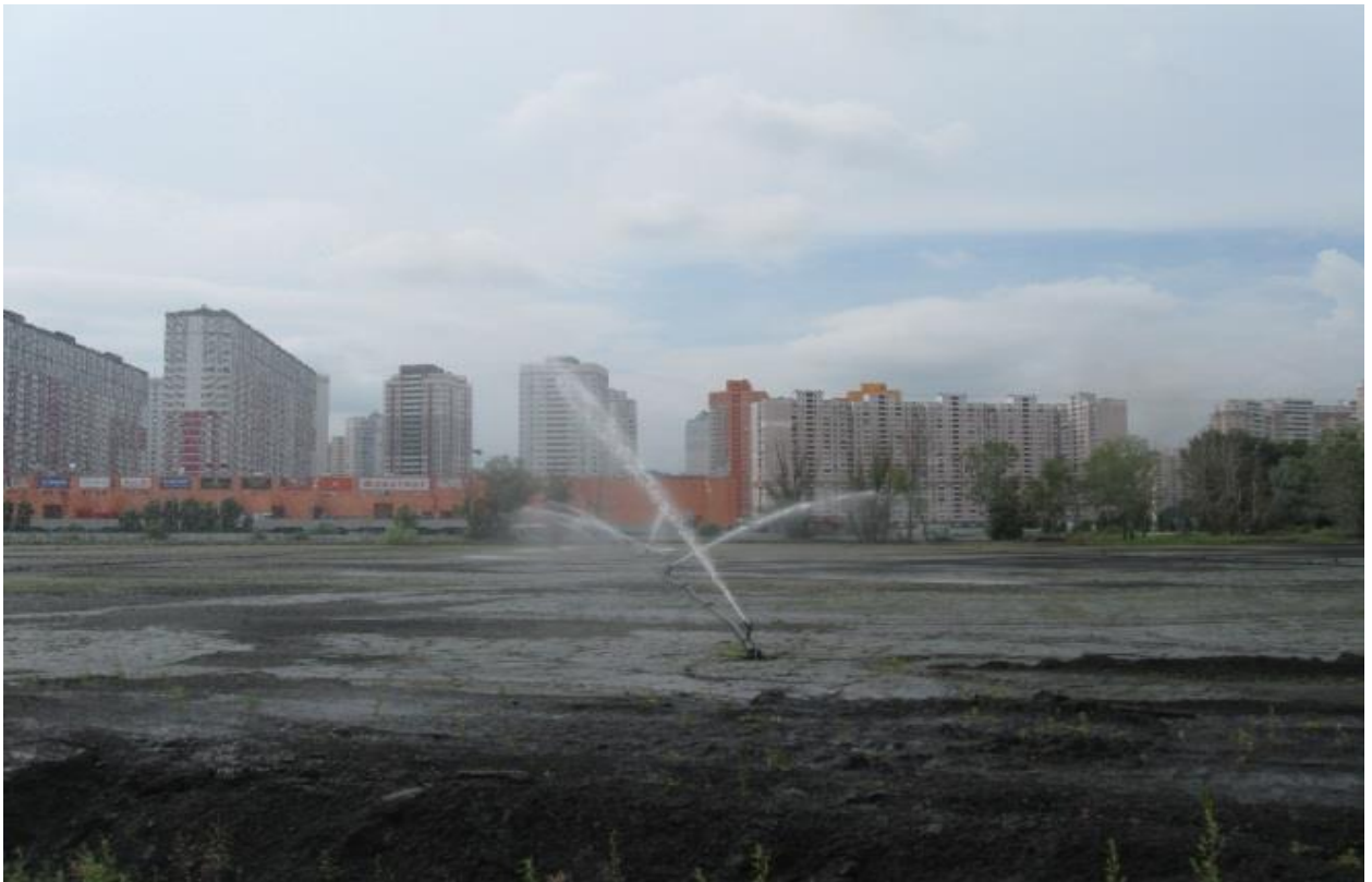
Рис. 2.6. Робота системи зрошення на секції № 1 золошлаковідвалу ТОВ «ЄВРО-РЕКОНСТРУКЦІЯ»
