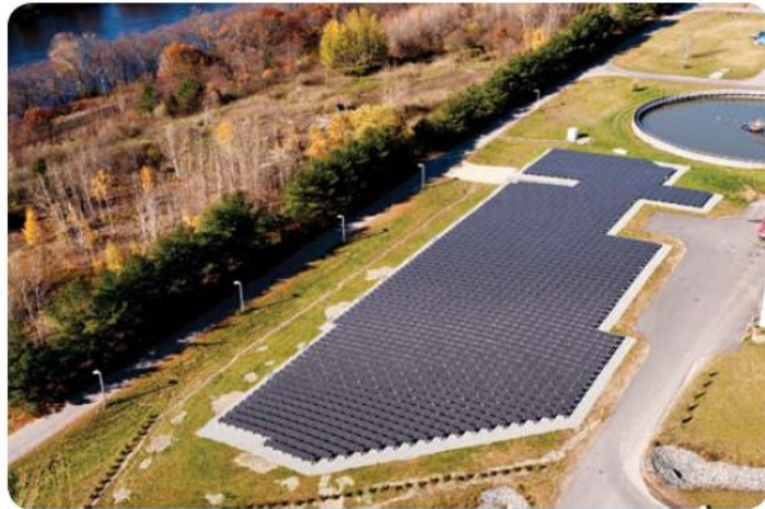
Рис.5.12 Сонячні батареї на колишньому санітарному звалищі району Грейтер Лоуренс (США) [156]
