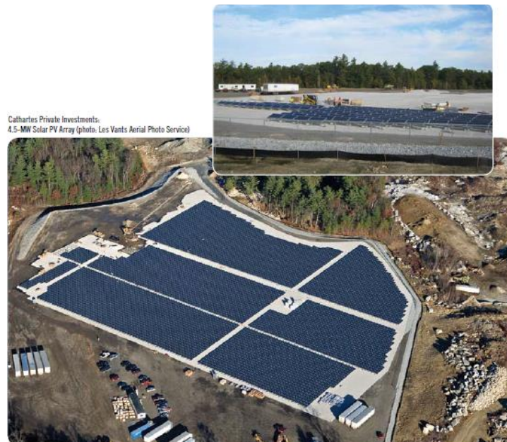
Рис. 5.13 Спорудження сонячних батарей на колишньому санітарному звалищі штат Массачусетс (США) [156]
