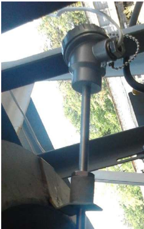
Рисунок М.2- Зовнішній вигляд термопар типу ТХА
