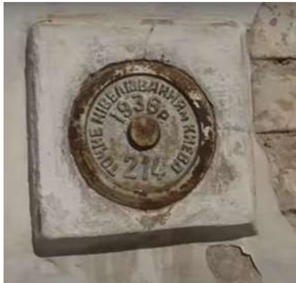
Стінний репер нівелювання (вул. Темірязєвська, 3)
